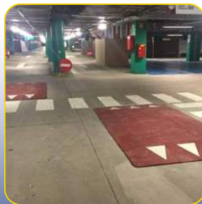
Paso elevado de Caucho "Cojín Berlínés" Con triángulos blancos para una mayor visibilidad
