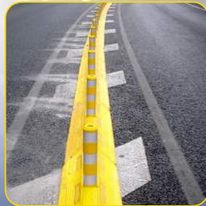
Delimitador D-36 Continuo Fabricado en poliuretano Alta flexibilidad
